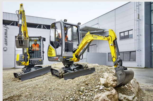
Les pelleteuses en action sur le chantier
